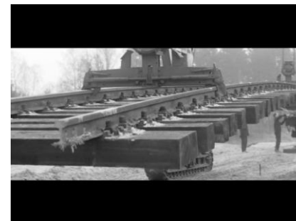
12. Pokládání kolejnic širokého rozchodu. Vlak ujíždí po širokorozchodné trati. Moderní hudba. 00:08:51 až 00:09:54
